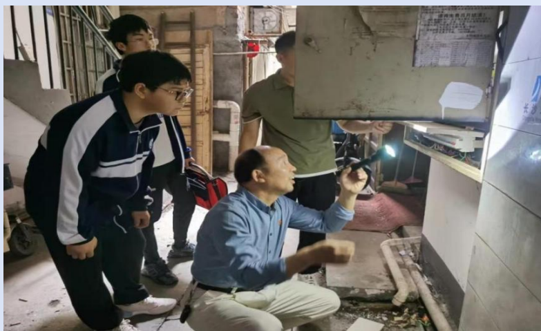
图 3-17 志愿服务队至长坡社区进行检查、维修公用照明线路
